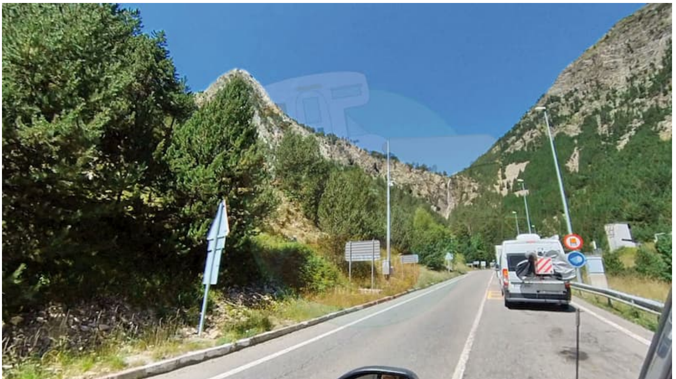
Tunnel de Bielsa
